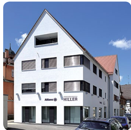
Passivhausneubau (mehrgeschossiger Holzbau) mit GUTEX Thermowall ® Putzfassade
