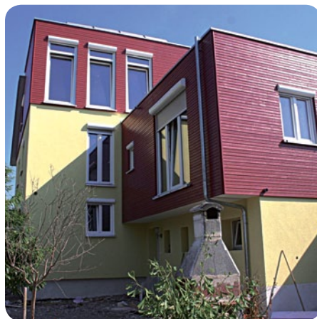
Sanierte DHH mit GUTEX Thermowall ®
