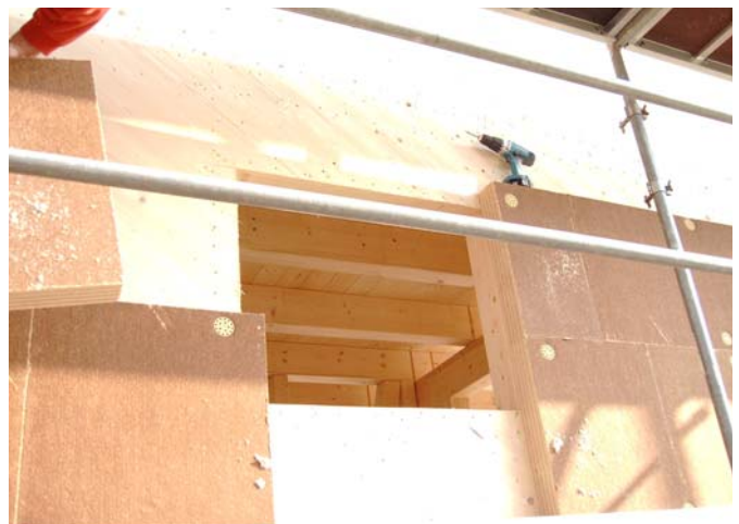
GUTEX Abb. 1 Anbringung der Außendämmung aus Holzfaserplatten
