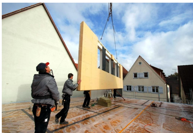
Abb. 4 a+b Die vormontierten Wandelemente werden auf der Baustelle zusammengefügt. (Quelle: GUTEX, Aufnahme Holzbau Walser)
